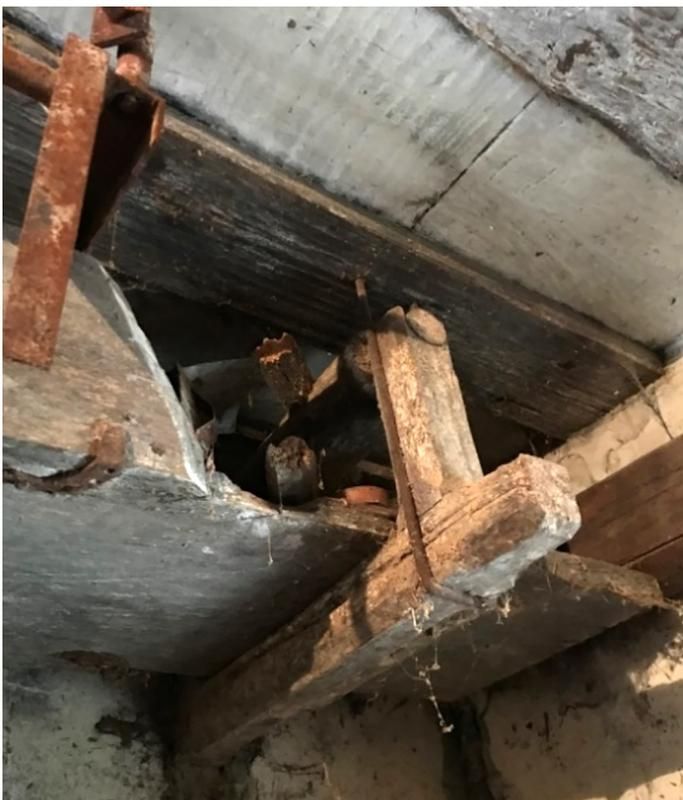
Schwarladen und Wellbaum mit abgebrochenem Hebelstab
