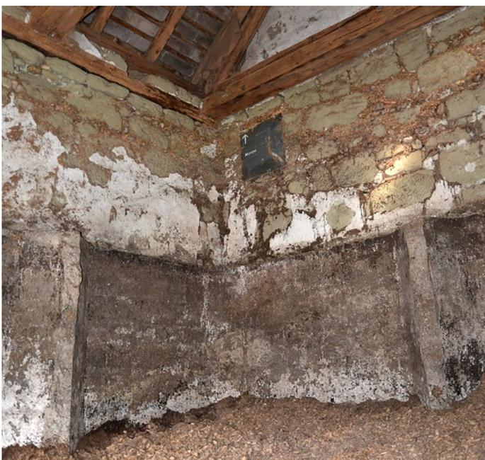
Heidenstock Oberbühl innen: Schnitzellager für Heizung, Wände 1. OG mit Zement verputzt, 2. OG Naturstein, darüber Balkenlage; Foto 2021
