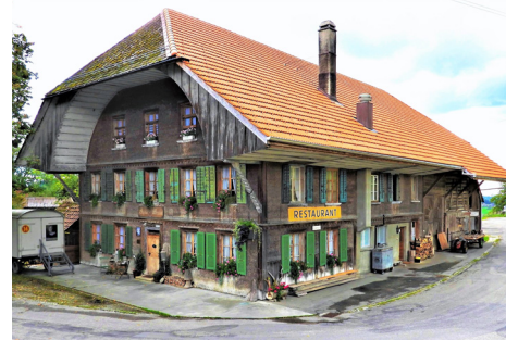
Speisewirtschaft Baujahr 1838, Anbau Scheune 1915
