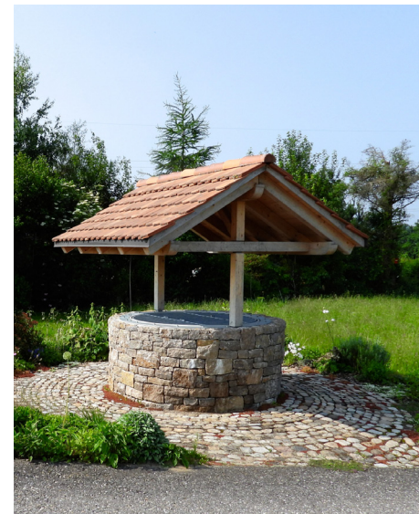
Sodbrunnen beim Käserhüsli, renoviert von Selina Zimmermann
