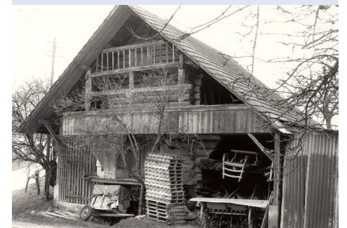
Speicher in Sollberg von 1641, Foto der Denkmalpflege des Kantons Bern
